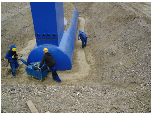
Compactación del relleno (izq.), tubería doble de seguridad de acero soldado (der.)
