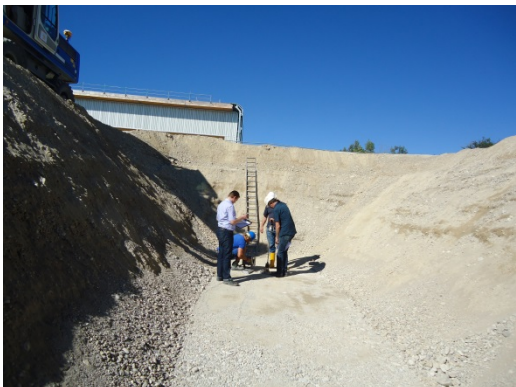
Control de compactación de la excavación (izq.), colocación del tanque de combustible (der.)
